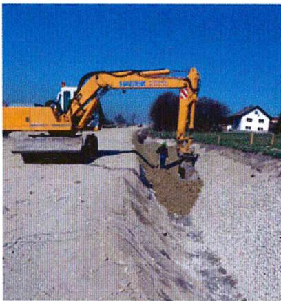
Die Drainagen sind eingebaut. Jetzt wird der Bahngruben ausgeformt und mit Lehm abgedichtet.
