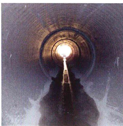
Licht am Ende des Tunnels: Abnahme der DN 1800 Rohrleitung, die Diepoltsdorf zukünftig Schutz vor Hochwasser bietet.
