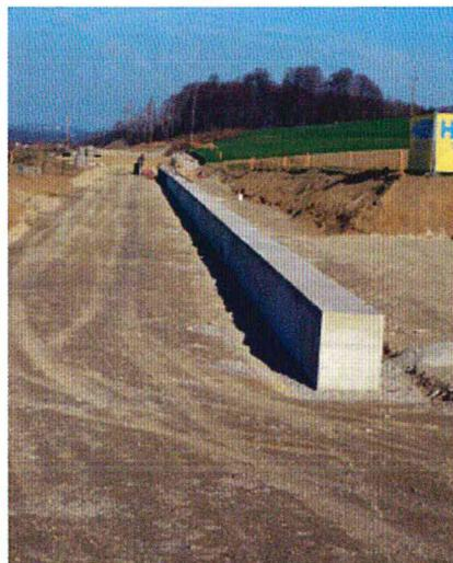
Ende Februar erreichten die Bauarbeiten die Haltestelle Diepoltsdorf. Im Bild das Bahnsteigfundament.
