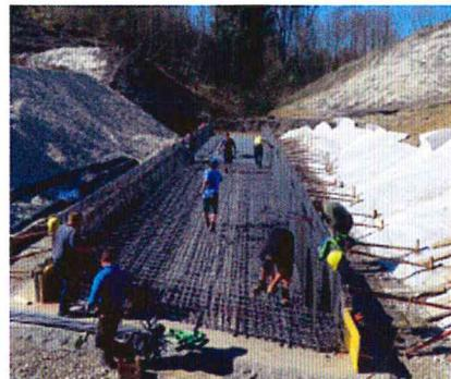
Anschließend beginnt der Bau des Durchlassbauwerks für den Bach. Auf diesen wird später ein acht Meter hoher Damm aufgebaut.
